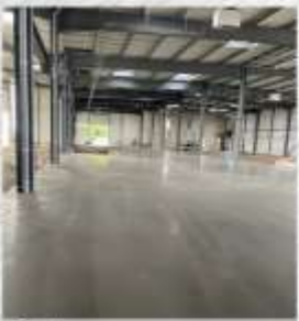
Dallage en cours
