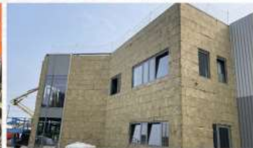
Isolation de la façade
