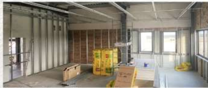
Réalisation de la partie bureau
