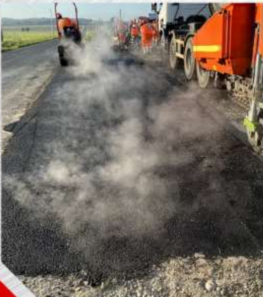
Enrobée tout chaud
