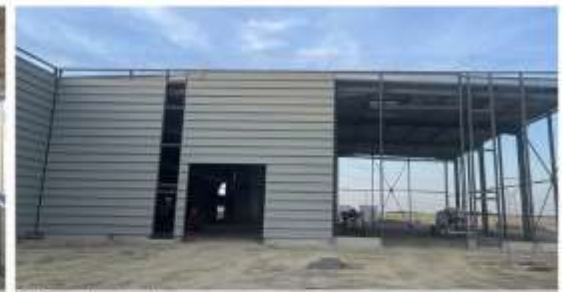
Pose du bardage
