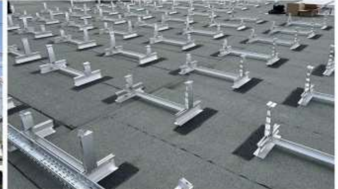
Plots support des panneaux photovoltaïques
